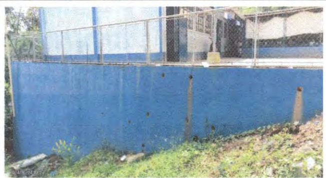
Foto 16: Pintura en muros exteriores e interiores.
