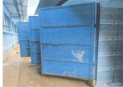
Foto 18: Mantenimiento a estructura (Lijado, Cambio de tubo, Cepillado, Sujeciones, Aplicación de Pintura) a puertas de Servicios Sanitarios
