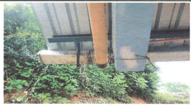
Foto 6: Sustrucción de canal de PVC
