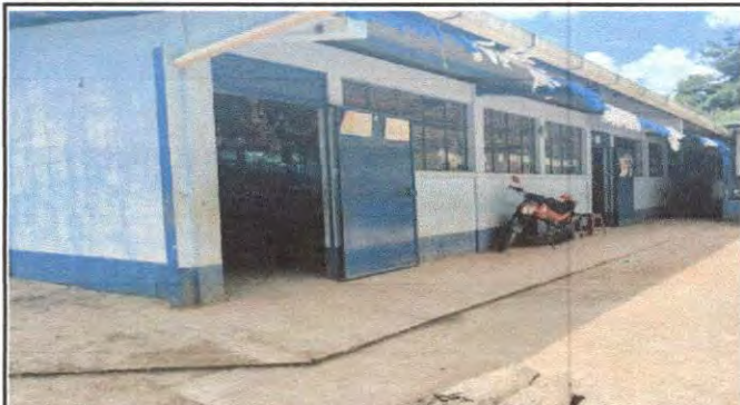
Foto 9: Pintura en muros exteriores e interiores
