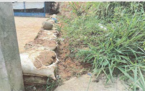
Foto 15: Reparación de cuneta de concreto ancho de 0.60
