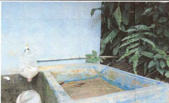
Foto 21: Sustitución de llave de chorro.
