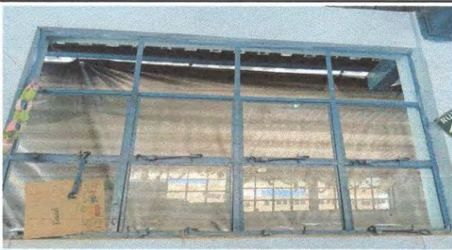
Foto 5: Sustrucción de vidrios.
