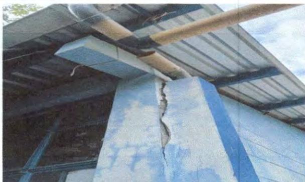
Foto 7: Sustrucción de bajada de agua pluvial, tubo PVC 3"
