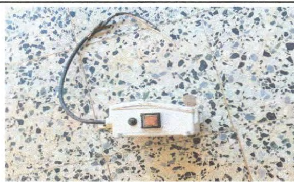
Foto 12: Sustrucción de flipones
