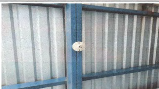
Foto 10: Sustrucción de lámparas tipo LED
