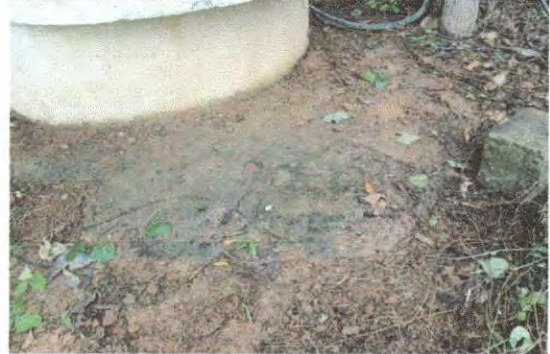
Foto 24: Sustitución de piso de torta de concreto.
