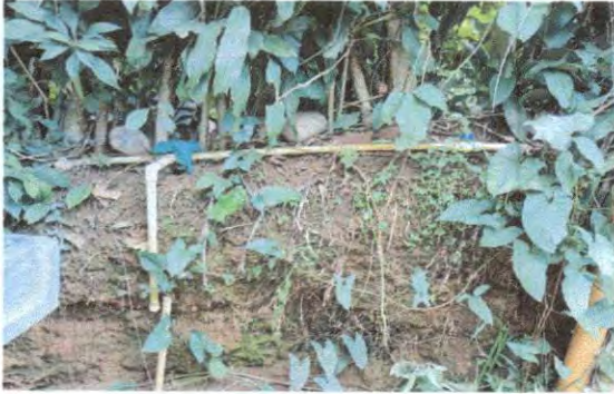
Foto 19: Sustitución de llave de paso.
