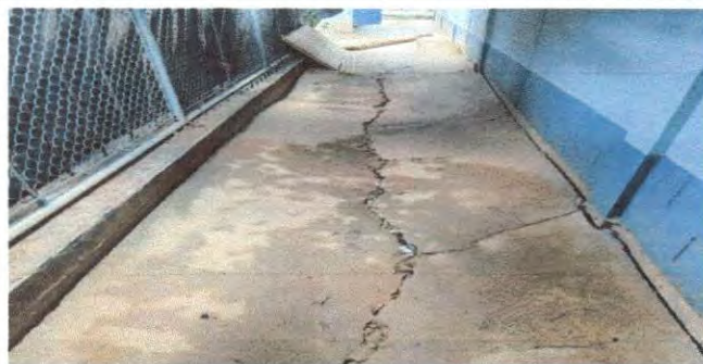
Foto 8: Reparación de banquetas de concreto
