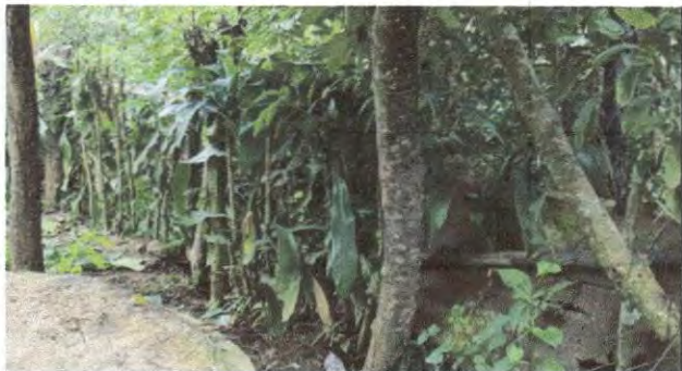
Foto 25: Reparación de cerco de alambre de pua
